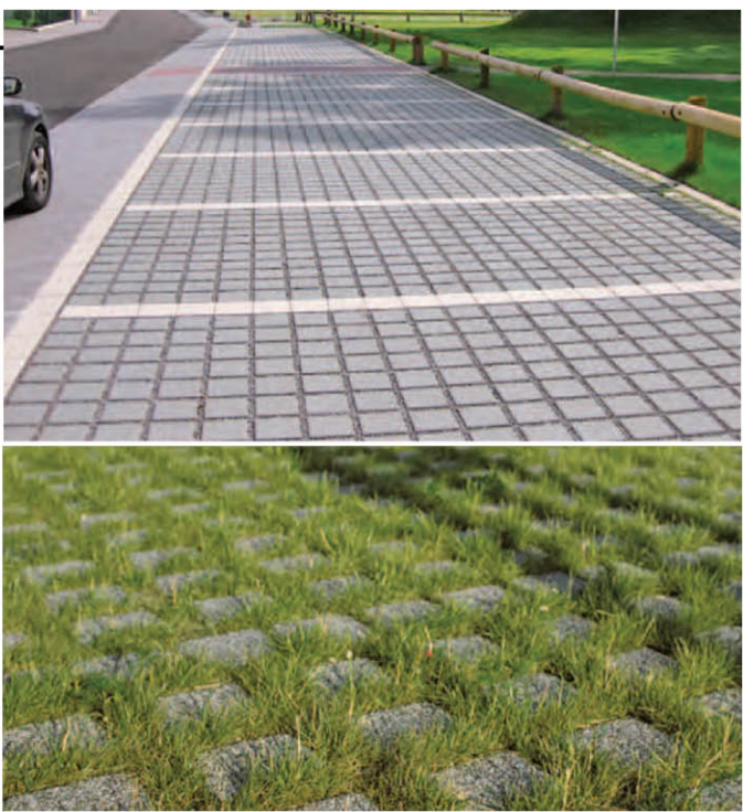
Parking: pavé à engazonnement
